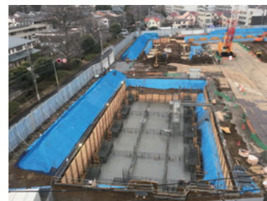
仮置き土砂の飛散防止対策状況
