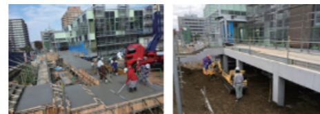
長谷工テクニカルセンターでのH-BAコンクリート施工風景
