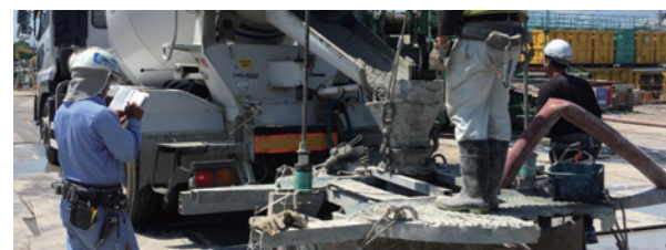
杭コンクリート打設
